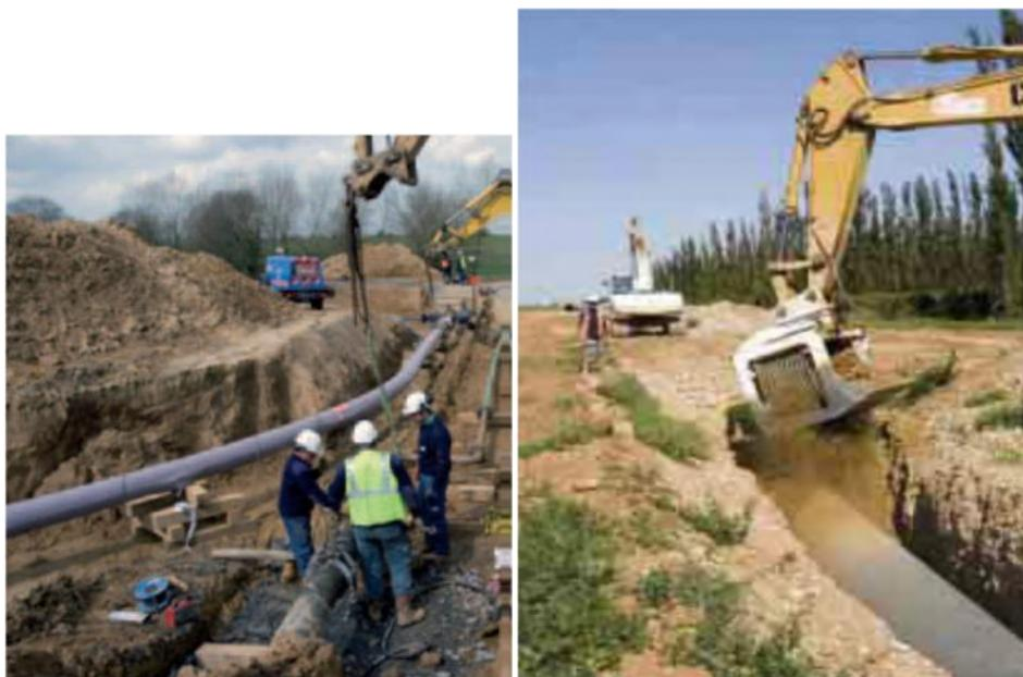
Figure n° 8 : Pose et remblai de la tranchée
