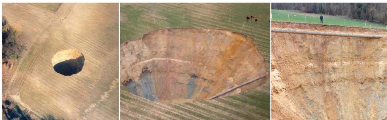
Figure n° 23 : Cratère consécutif à l'effondrement d'une carrière découvrant une canalisation
